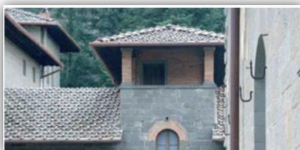
Il tetto del castello di Acquabella con le tegole installate
